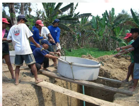
Construction de latrines dans un camp en Thaïlande
